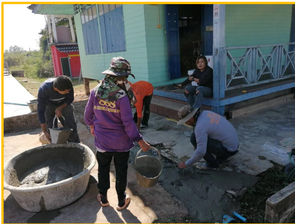
รูปที่ ๑๑ ปรับปรุงซ่อมแซมอาคารเรียน
